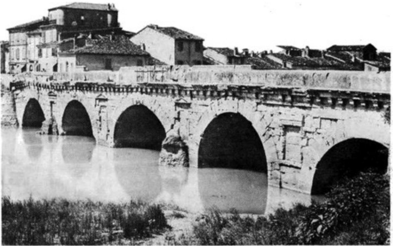
Puente construido por los ingenieros del ejército romano en Rímini.
