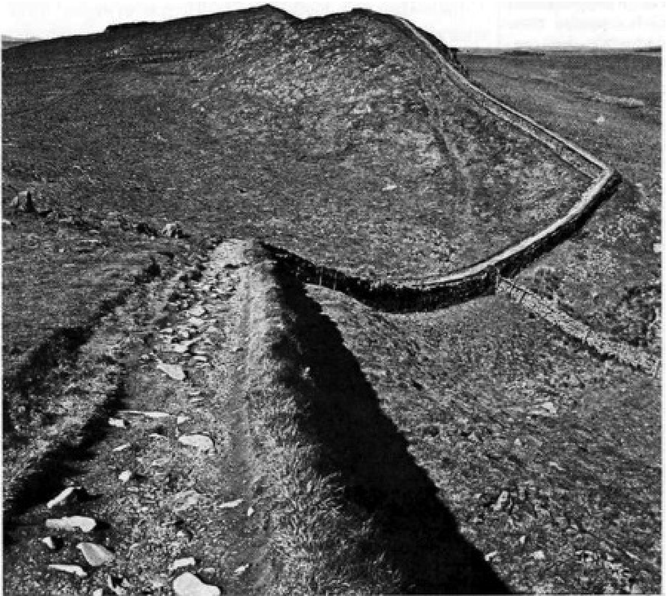
Muro hecho construir por Adriano, en el año 122.
